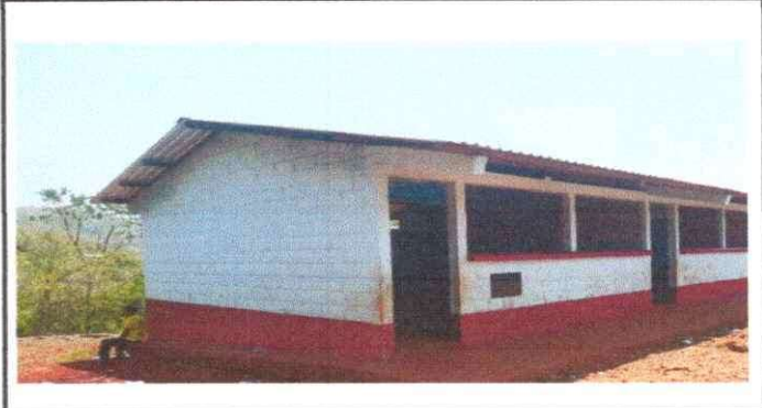
Foto 2: Sustitucion de 02 puertas de metal del edificio educativo de la ventaneria.
