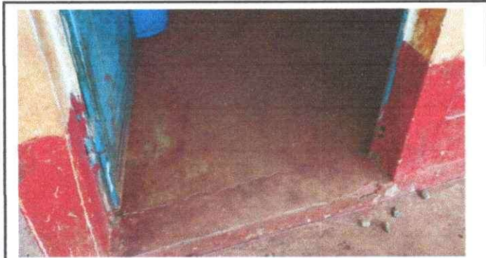
Foto 3: Sustitucion de piso de las aulas y corredor del edificio educativo
