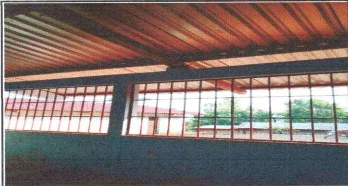
Foto 1: Sustitucion de Laminas y estructura Metalica.
